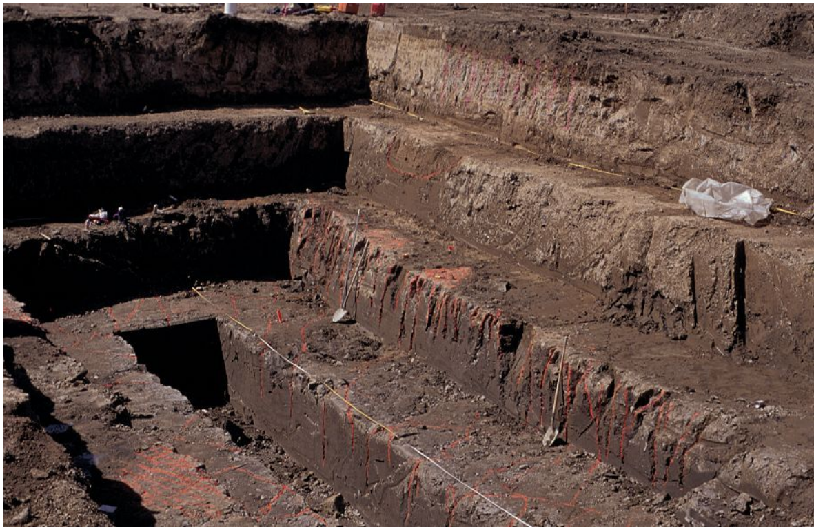
Laidlaw ned til 6 meter under terræn
